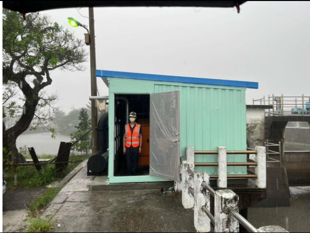
清水區武鹿排水已預佈完成。
