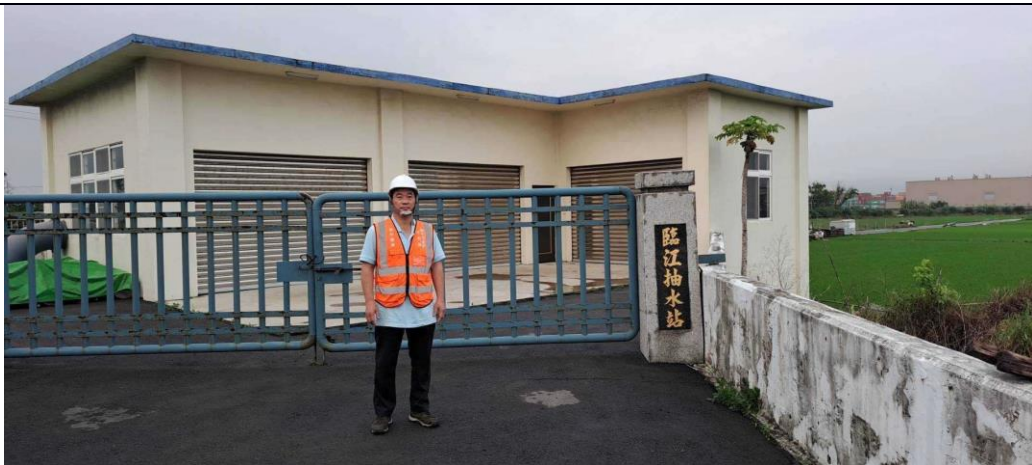
清水區臨江抽水站預佈完成。
